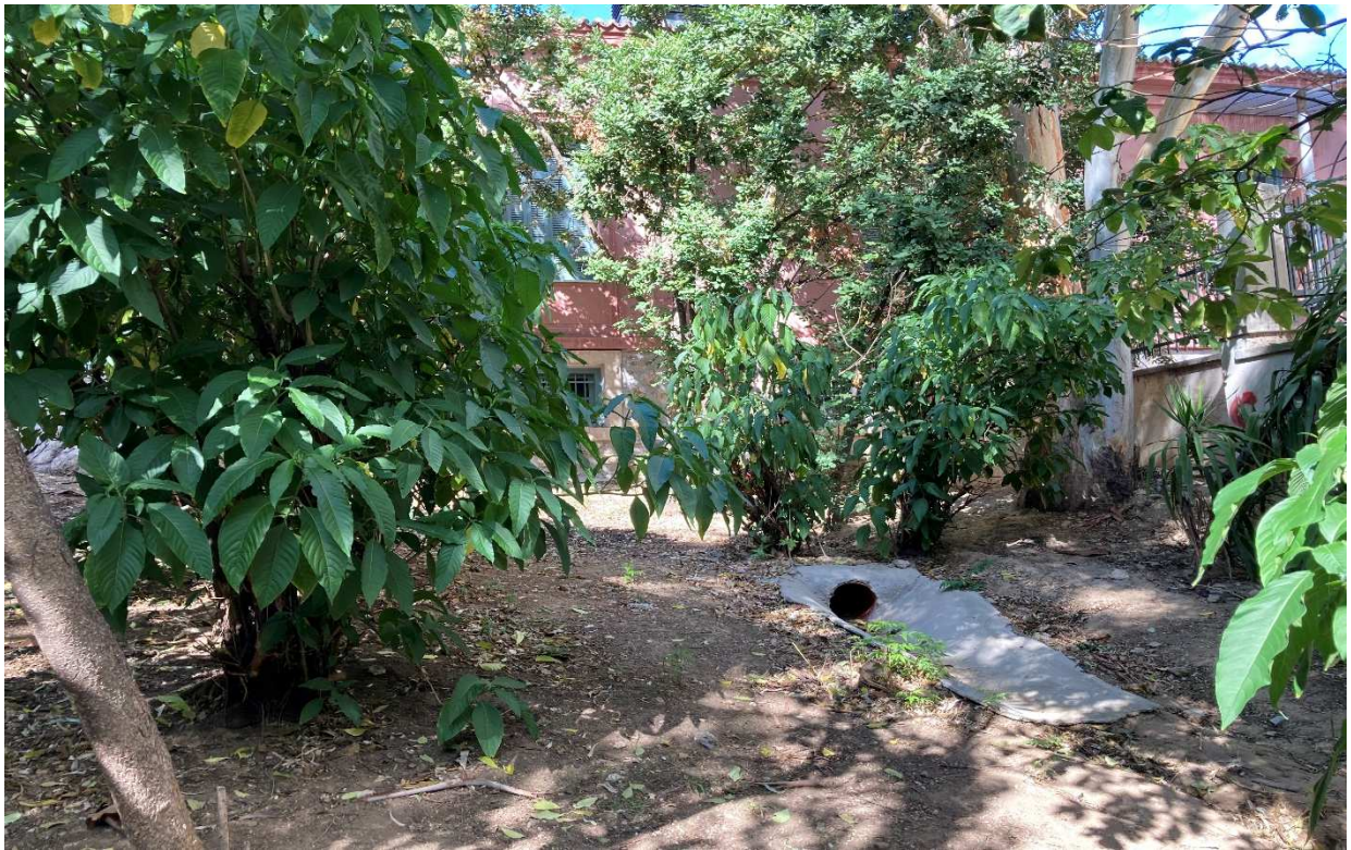
ΦΩΤ.9 : Προσωρινή εκροή σε επιφανειακό έργο εξόδου στο αριστερό παρτέρι Ιατρίδου, η οποία καταργήθηκε, μετά από διαμαρτυρία των παρόδων ιδιοκτητών (άποψη προς τα ανάντη)
