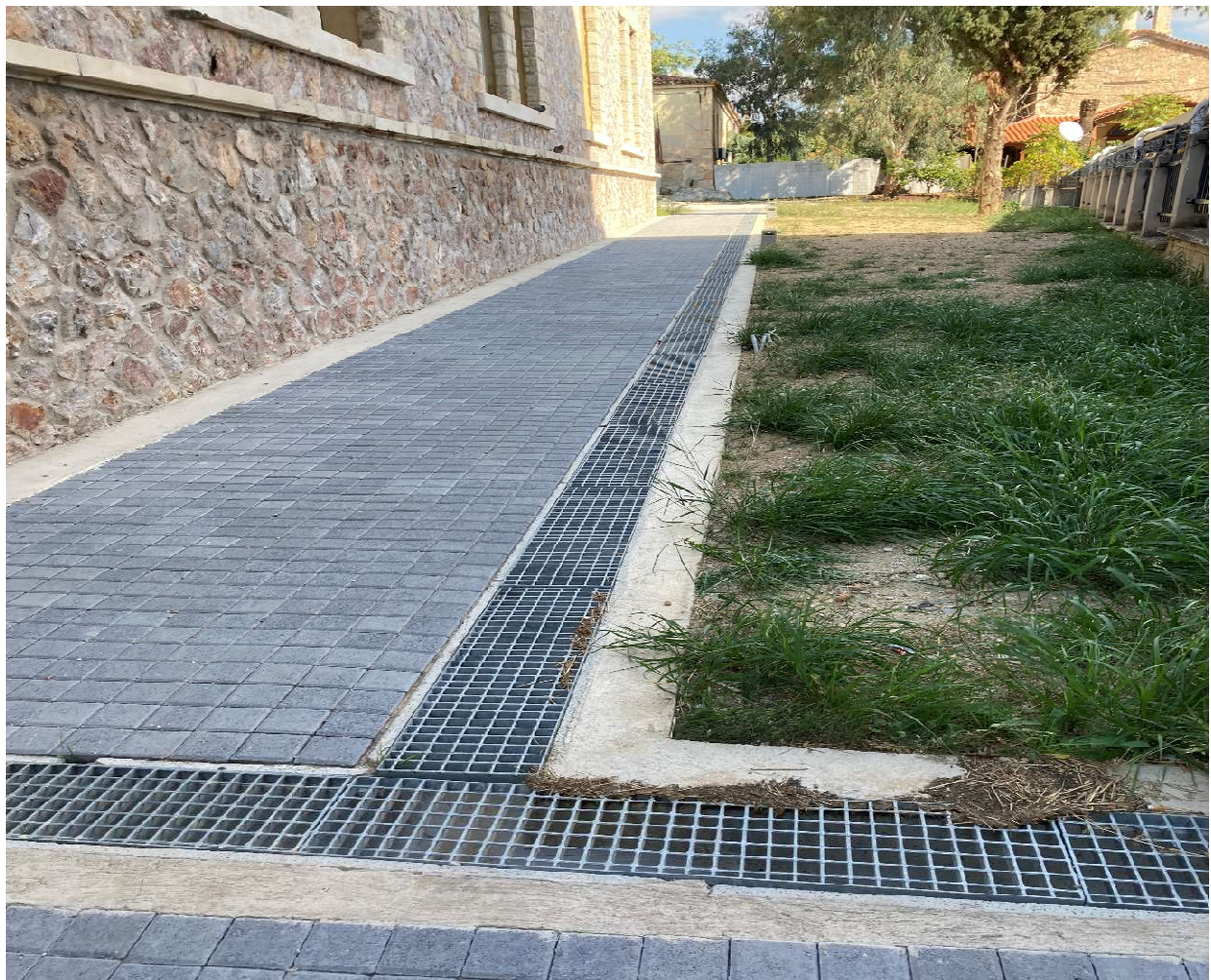
ΦΩΤ.6 : Κανάλι με εσχάρα υδροσυλλογής K5 (νότια) με σύνδεση προς αποχέτευση με τον εξωτερικό αγωγό D 250mm, στη μάντρα του συγκροτήματος με το ΝΙΜΤΣ (άποψη προς τα ανάντη)
