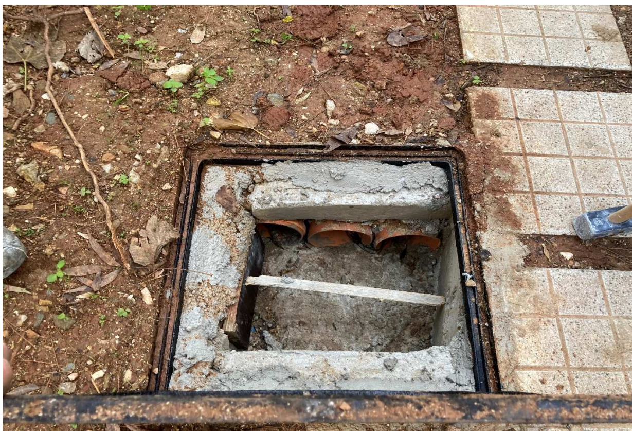
ΦΩΤ.12 : Νέο σύστημα αποροής με σχεδόν επιφανειακούς αγωγούς, που αντικατέστησε το έργο εξόδου που καλύφθηκε (άποψη κατάντη φρεατίου, όπου φαίνονται οι 3 x D 150mm αγωγοί)
