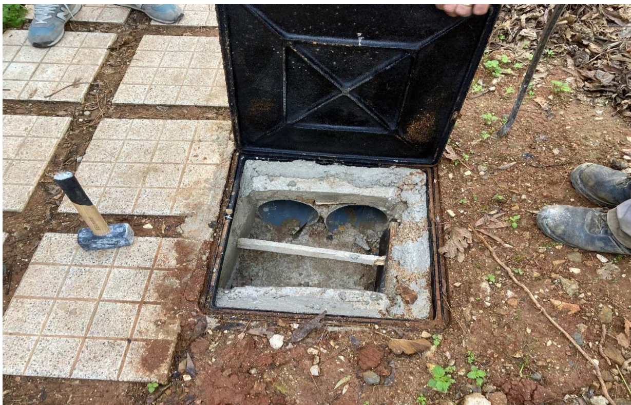
ΦΩΤ.11 : Νέο σύστημα αποροής με σχεδόν επιφανειακούς αγωγούς, που αντικατέστησε το έργο εξόδου που καλύφθηκε (άποψη του φρεατίου, όπου φαίνονται οι 2 x D 200mm αγωγοί)
