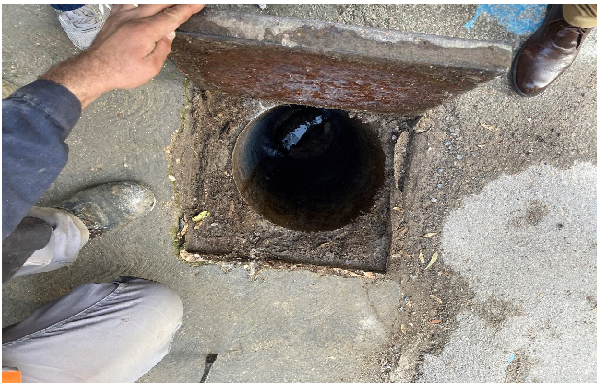
ΦΩΤ.4 : Ανοιγμένο κάλυμμα παραπάνω φρεατίου υφιστάμενου αγωγού ομβρίων Ιατρίδου προς Σουηδίας, στη διασταύρωση
