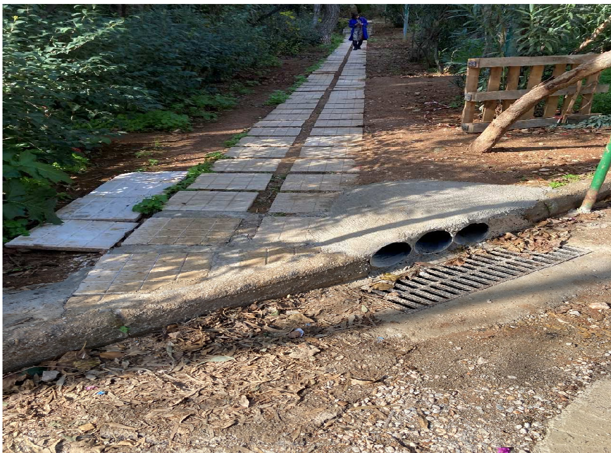
ΦΩΤ.13 : Νέο σύστημα αποροής με σχεδόν επιφανειακούς αγωγούς, που αντικατέστησε το έργο εξόδου (άποψη προς τα ανάντη με τους 3 x D 150mm στο κράσπεδο – φρ. υδροσυλλογής Ιατρίδου)
