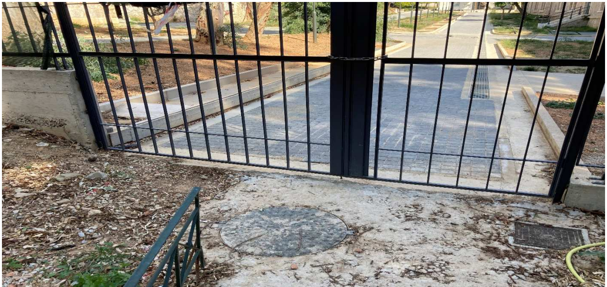
ΦΩΤ.5 : Φρεάτιο αρχής Φ4 νέου έργου απορροής μελέτης, μπροστά από τη δυτική πύλη του συγκροτήματος κτηρίων (άποψη προς τα ανάντη, όπου φαίνεται κανάλι με εσχάρα υδροσυλλογής)
