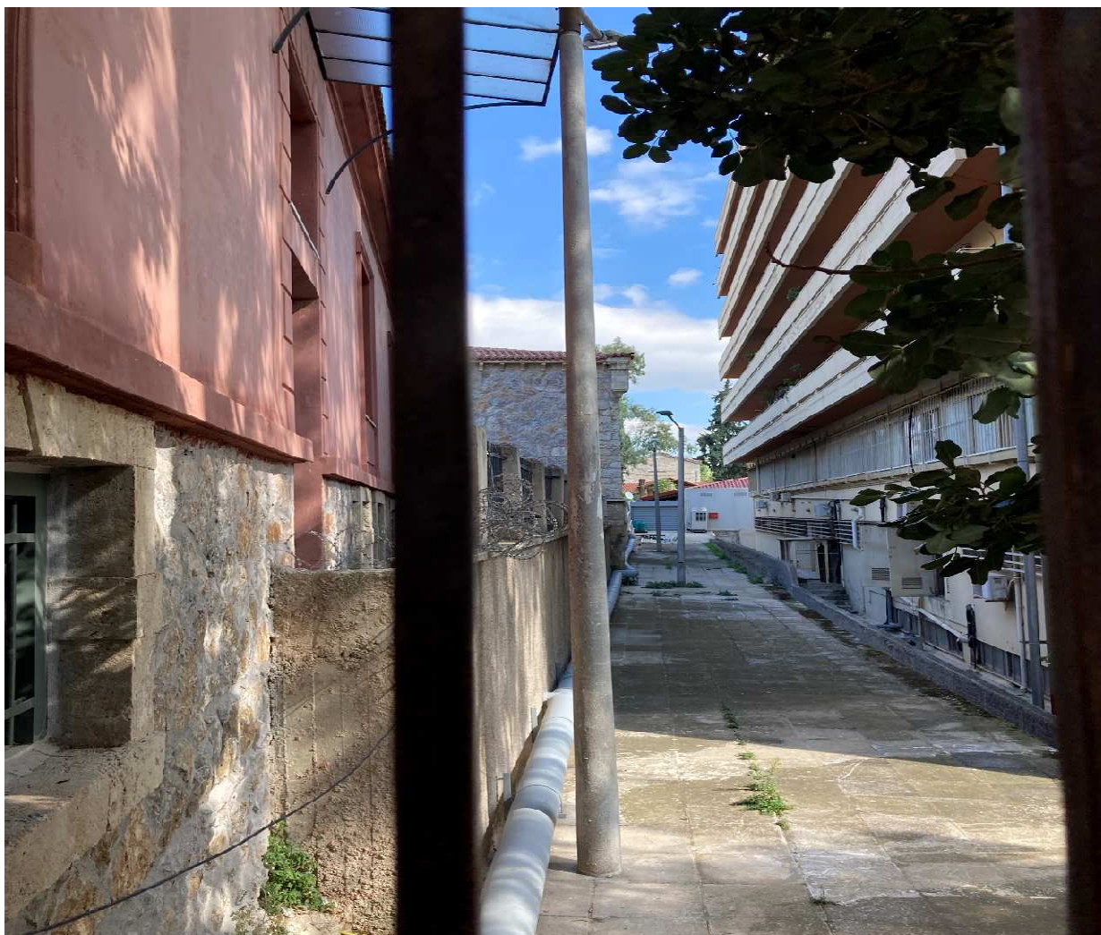
ΦΩΤ.7 : Αναρτημένος εξωτερικός αγωγός D 250mm, στη μάντρα του συγκροτήματος με το ΝΙΜΤΣ (άποψη προς τα ανάντη)
