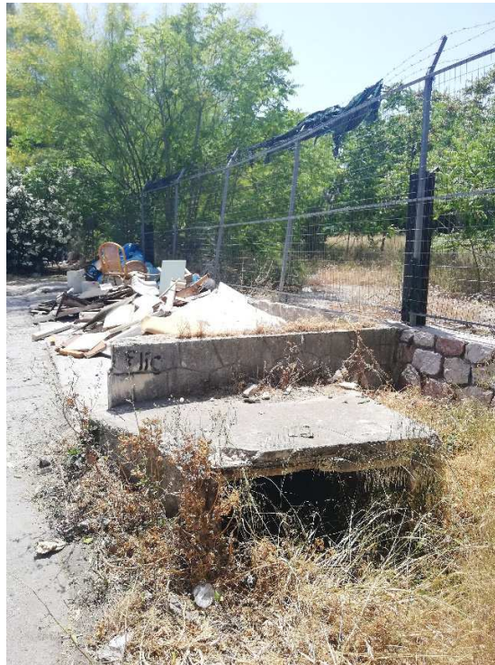
Φωτογραφία Φ9. Πέρασ αγωγού επί του πεζοδρομίου της οδού Ακρωτηρίου
