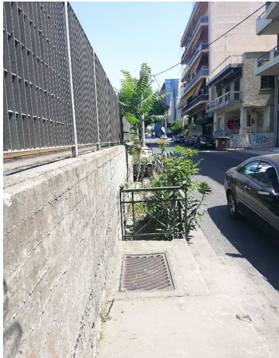
Φωτογραφία Φ4. Ανάντη (ανατολικό) τεχνικό εγκάρσιων αγωγών ΗΣΑΠ επί της οδού Ηρακλείου
