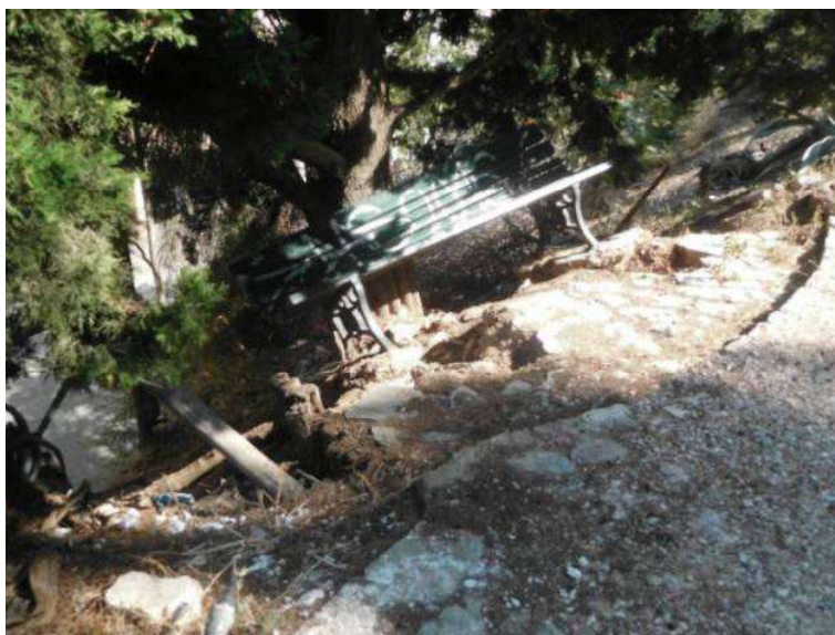
Φωτ. 8: Ενδείξεις εδαφικής αστάθειας στο ανώτερο τμήμα του πρानούς επί της οδού Σαρανταπήχου.
