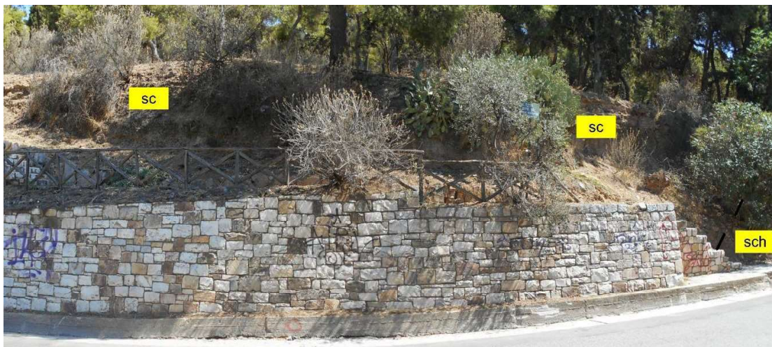
Φωτ.24. Άποψη του ΝΑ/κού τμήματος του πρανούς, όπου τα κορηματικά υλικά επικάθονται επί των σχιστολίθων.
