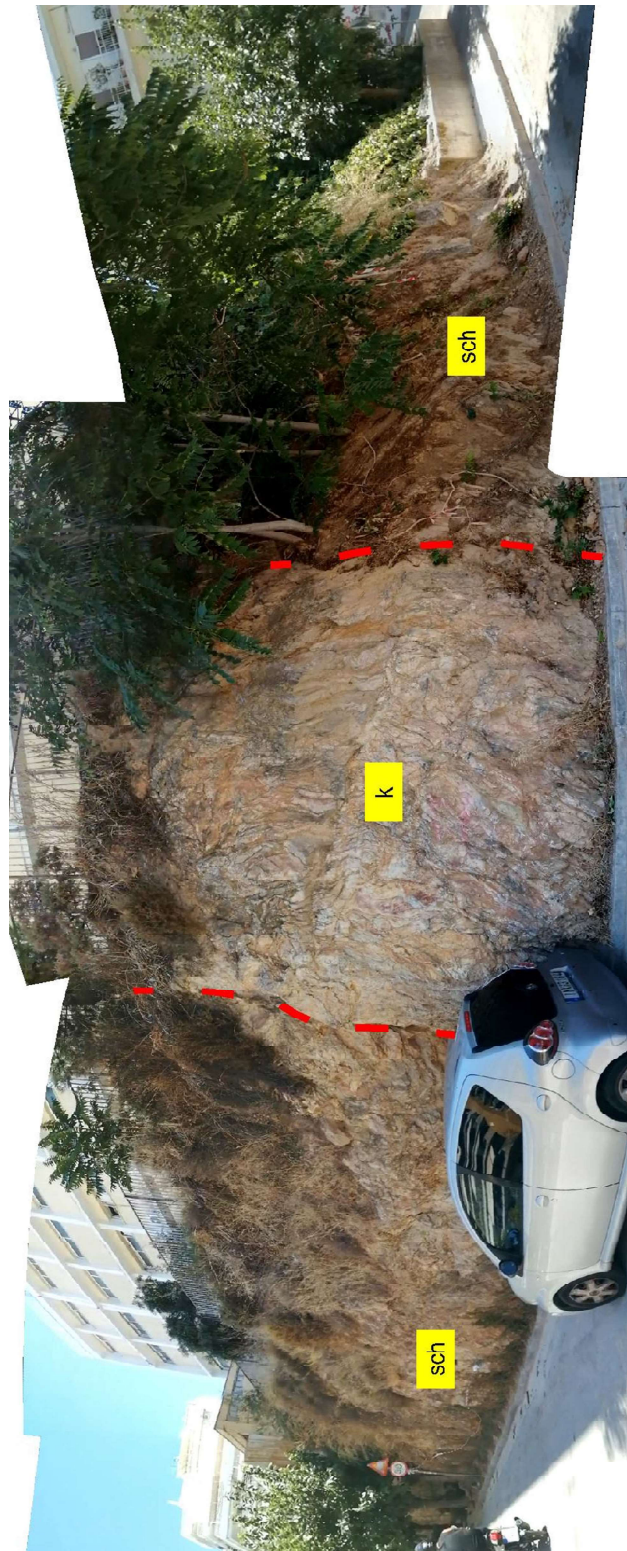
Φωτ.6. Άποψη του πρανούς Α2. Συμβολισμοί. k: ασβεστόλιθος, sch: σχιστόλιθος, διακεκομμένη κόκκινη γραμμή: ρήγμα.
