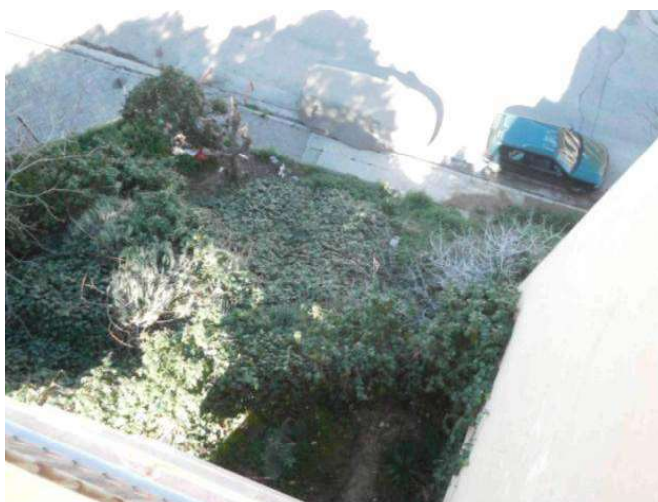
Φωτ. 4: Άποψη δευτέρου τμήματος στη συμβολή των οδών Νικάνορος και Πυθίας, θέση στην οποία η γωνία του σχολικού κτιρίου βρίσκεται επί του πρानούς (λήψη από πάνω).
