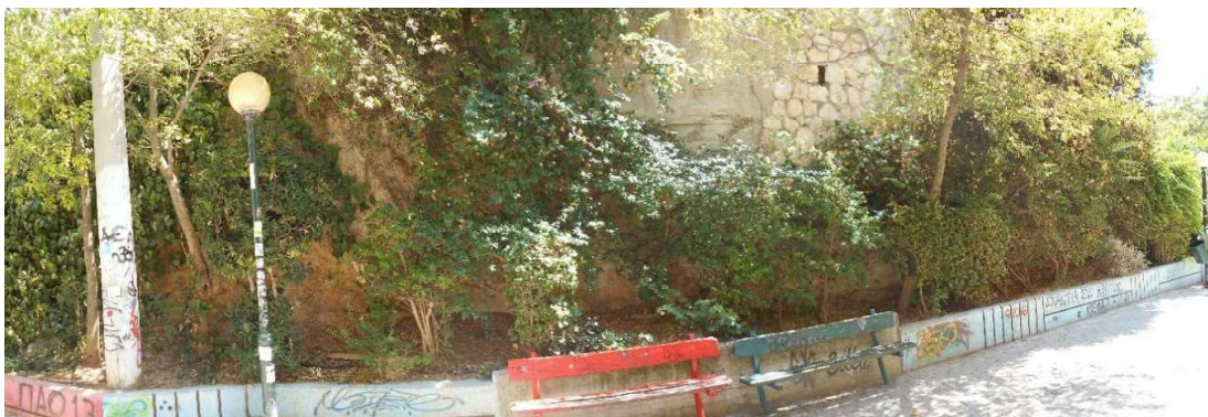
Φωτ.11. Άποψη του νότιου τμήματος του πρανούς Β2.
