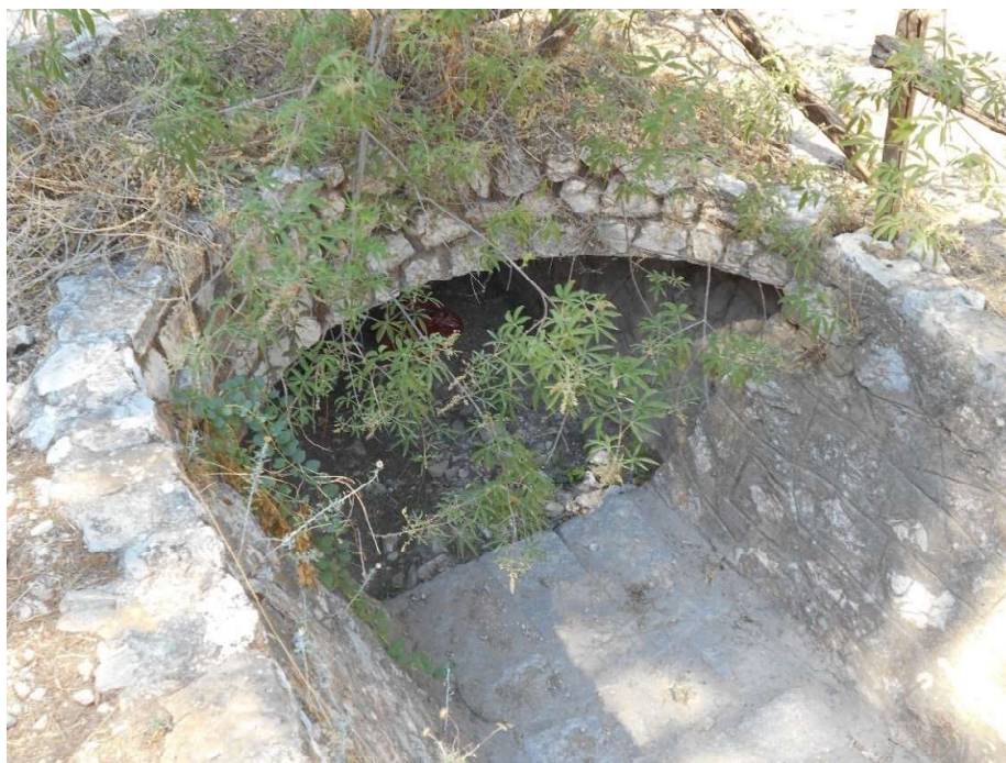
Φωτ.20. Άποψη του υφιστάμενου στεγανού οχετού ομβρίων που διέρχεται ανεπένδυτος κάτω από την οδό για το Λόφο του Λυκαβηττού.
