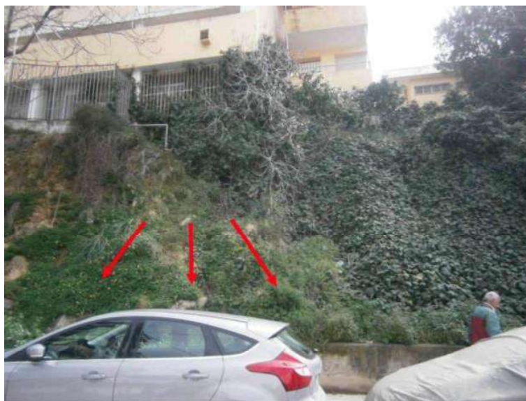
Φωτ. 5: Άποψη του δεύτερου τμήματος (συμβολή των οδών Πυθίας και Νικάνορος), διακρίνεται η πίσω πλευρά του σχολικού κτιρίου και η ζώνη των καταπτώσεων στην όψη του πρανούς.
