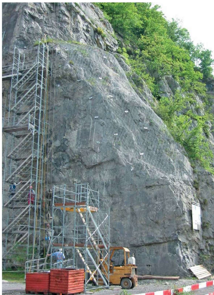
Εικ.16. Ενδεικτική εφαρμογή μεταλλικού πλέγματος προστασίας ( https://www.geobruug.com ).
