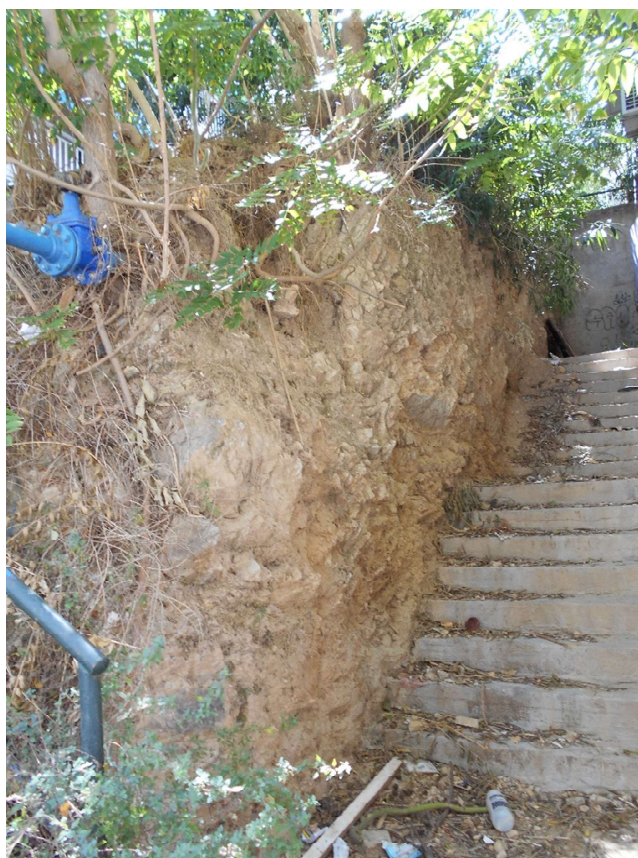
Φωτ.14. Άποψη του πρανούς από τα βόρεια. Διακρίνονται οι ασβεστολιθικές ενστρώσεις εντός των σχιστολίθων.
