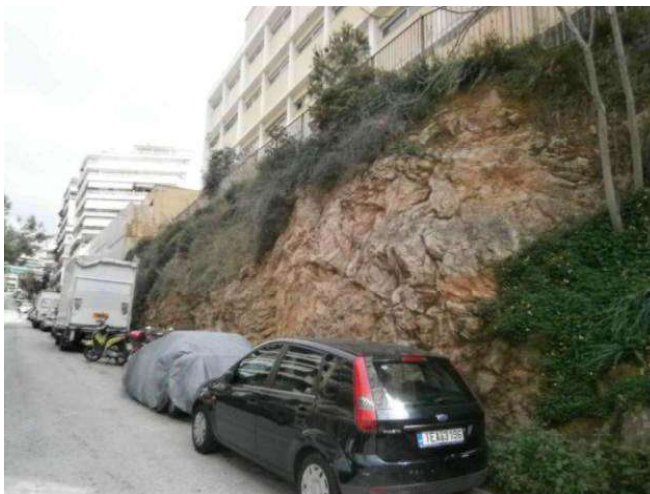
Φωτ. 3: Άποψη του πρώτου τμήματος επί της οδού Πυθίας στο οποίο θα πραγματοποιηθούν εκσκαφές για διαμόρφωση πεζοδρομίου, διακρίνεται η πίσω πλευρά του 39ου Λυκείου Αθήνας.
