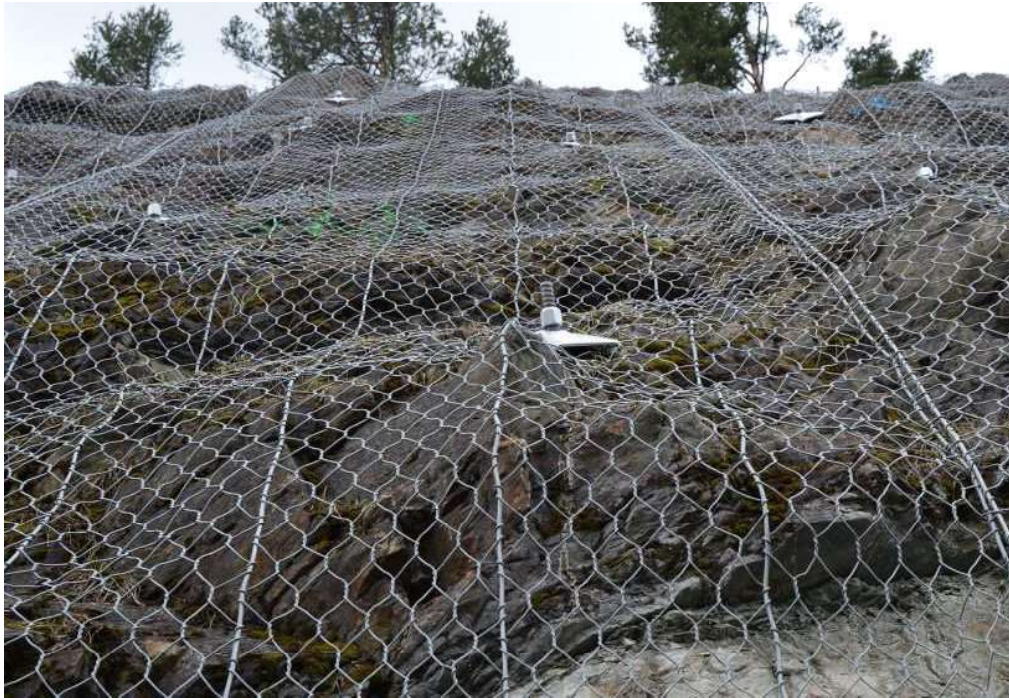
Εικ.17. Λεπτομέρεια εφαρμογής ενδεικτικού μεταλλικού πλέγματος προστασίας ( https://www.maccaferri.com ).
