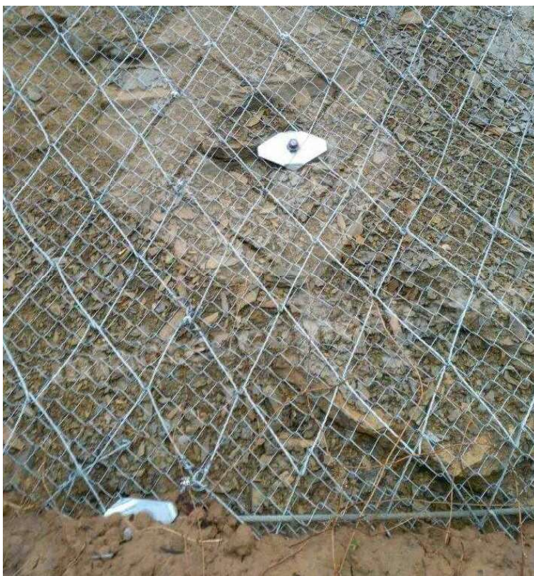
Εικ.36. Ενδεικτική εφαρμογή μεταλλικού πλέγματος προστασίας ( https://www.geobruug.com ).
