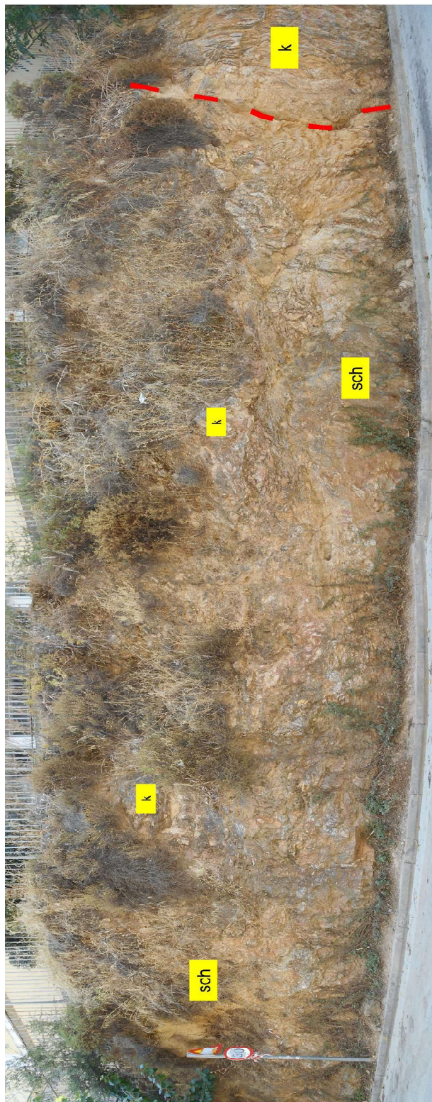
Φωτ.7. Άποψη του ανατολικού τμήματος του πρανούς Α2, ενδεικτική των ασβεστολιθικών παρεμβολών. Συμβολισμοί: k: ασβεστόλιθος, sch: σχιστόλιθος, διακεκομμένη γραμμή: ρήγμα.
