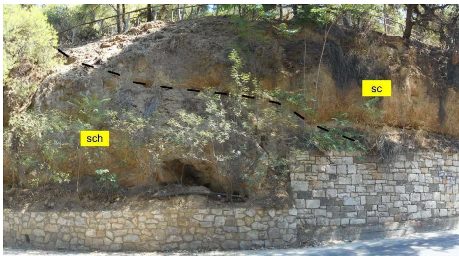
Φωτ.23. Άποψη του ΒΔ/κού τμήματος του πρανούς, όπου τα κορηματικά υλικά επικάθονται επί των σχιστολίθων.
