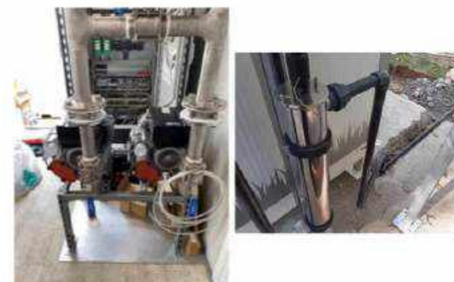
Εικόνα 92: Λεπτομέρειες εγκαταστάσεων του έργου. Πηγή: Δήμος Αθηναίων
