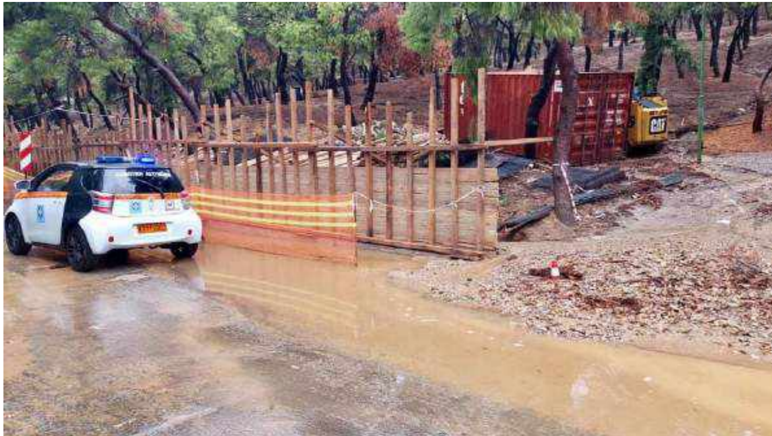
Εικόνα 82: Αντιπλημμυρικά έργα. Πηγή: Δήμος Αθηναίων
