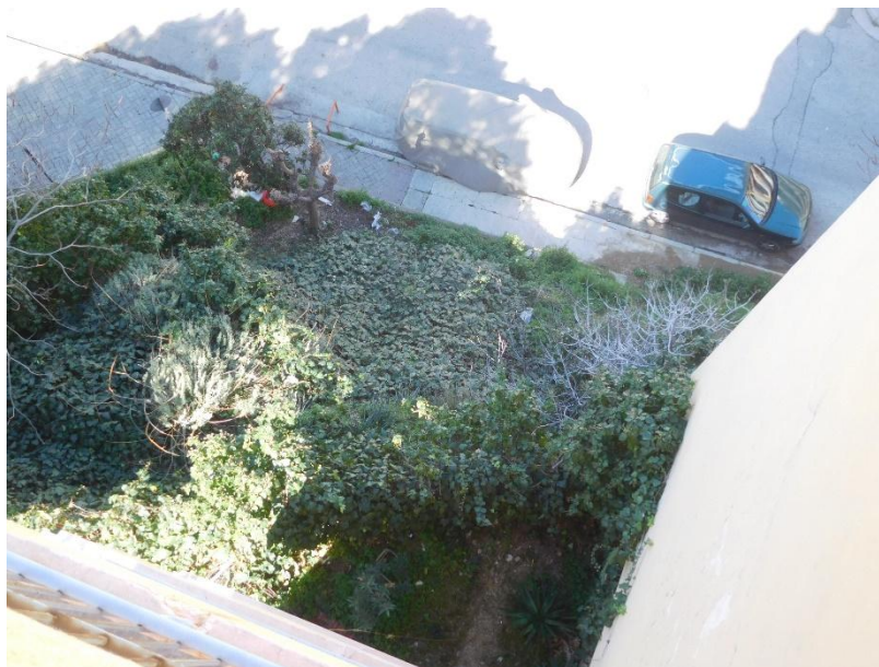
Φωτ. 4: Άποψη δευτέρου τμήματος στη συμβολή των οδών Νικάνορος και Πυθίας, θέση στην οποία η γωνία του σχολικού κτιρίου βρίσκεται επί του πρανούς (λήψη από πάνω).
