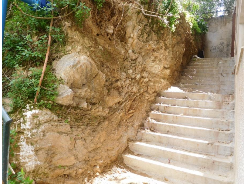
Φωτ. 7: Άποψη του πρανούς επί της οδού Μπουκουβάλα, διακρίνονται τα πεσμένα τεμάχια στη βάση του και η υποβαθμισμένη ποιότητα του Αθ. Σχιστολίθου.
