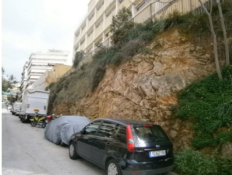
Φωτ. 3: Άποψη του πρώτου τμήματος επί της οδού Πυθίας στο οποίο θα πραγματοποιηθούν εκσκαφές για διαμόρφωση πεζοδρομίου, διακρίνεται η πίσω πλευρά του 39 ου Λυκείου Αθήνας.
