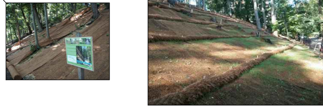
ΣΤΑΘΕΡΟΠΟΙΗΤΙΚΗ ΕΠΙΣΤΡΟΦΗ ΔΙΑΒΡΩΜΕΝΩΝ ΠΕΡΙΟΧΩΝ ΚΑΙ ΣΥΓΚΕΝΤΡΩΣΕΩΝ ΧΑΛΙΚΟΝΩΝ ΜΕ ΕΙΔΙΚΑ ΓΕΩΣΥΝΘΕΤΑ ΠΡΑΣΙΝΗΣ ΤΕΧΝΟΛΟΓΙΑΣ (ΠΡΟΕΤΟΙΜΑΣΙΑ ΓΙΑ ΜΕΛΟΝΤΙΚΗ ΦΥΤΕΥΣΗ)
